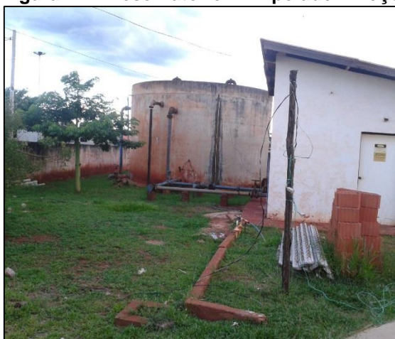
Figura 11 – Reservatório R1 Apoiado – Poço SEV-003.
